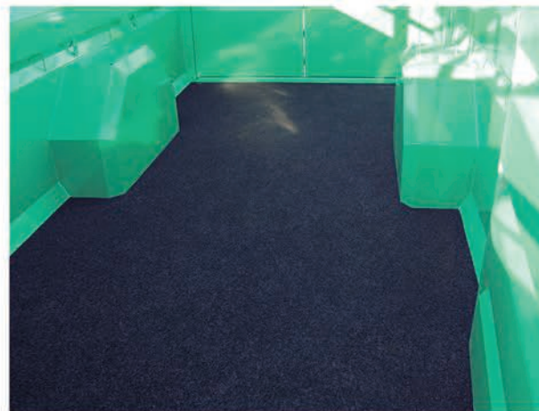
PISO CUBIERTO DE RESINA / PLANCHER COUVERT DE RÉSINE
